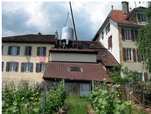
Pose d'une cuve de macération automatique. Le progrès tombe du ciel, mais le raisin vient toujours de la vigne!
