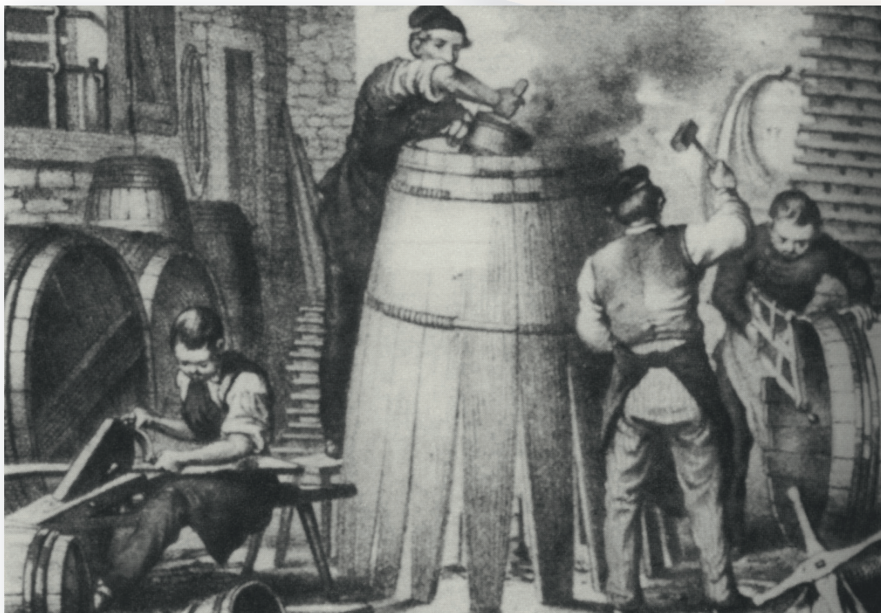
Un tonneau – peut-être destiné à contenir du pinot noir aussi bon que celui de Bourgogne – en cours de montage dans les années 1840. (Illustration reprise du Vignolant de mai 1985.)
